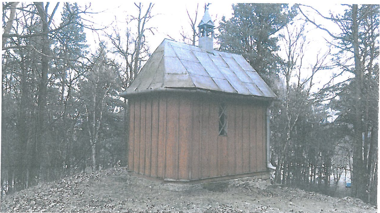
Fot. 3 Elewacja południowo-zachodnia – boczna i tylna
