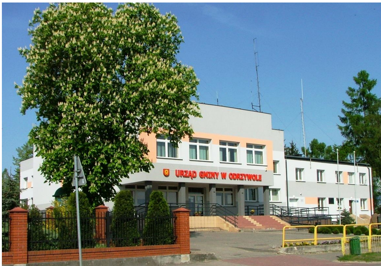
Budynek Urzędu Gminy po modernizacji
