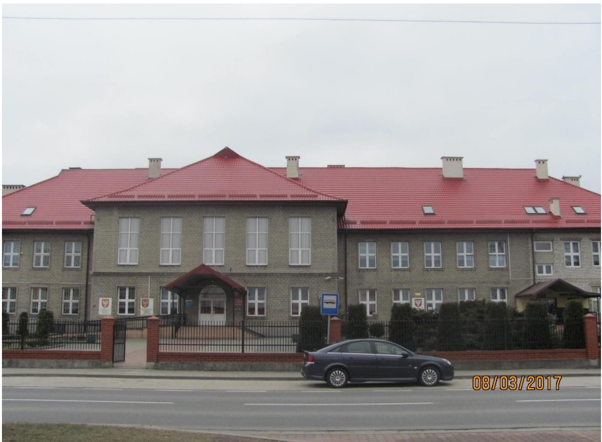
Budynek szkoły przed modernizacją
