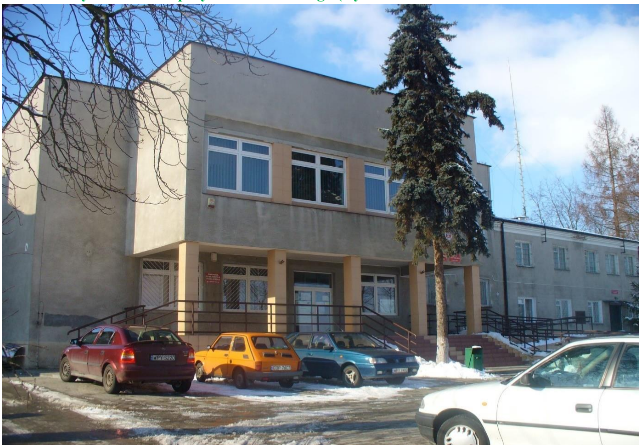
Budynek Urzędu Gminy przed modernizacją
